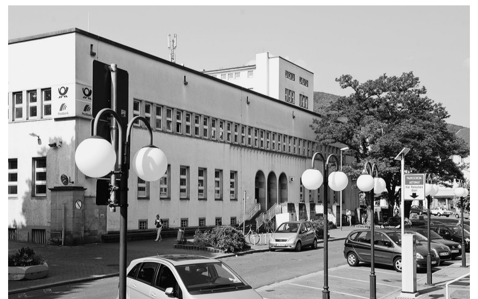
Die Hauptpost in Neustadt a. d. Weinstraße. Im Kellergeschoss des Gebäudes wurden massive Undichtigkeiten durch zeitweise aufstauendes Sickerwasser festgestellt, 130 m² Wandfläche musste mit einer Rasterinjektion abgedichtet werden. FOTO: DRYTECH
