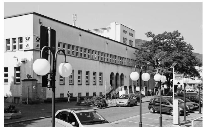
Die Hauptpost in Neustadt a. d. Weinstraße. Im Kellergeschoss des Gebäudes wurden massive Undichtigkeiten durch zeitweise aufstauendes Sickerwasser festgestellt, 130 m² Wandfläche musste mit einer Rasterinjektion abgedichtet werden. FOTO: DRYTECH
